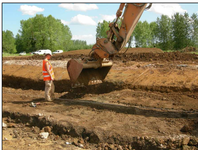
Au grattage : décapage des couches d'habitat
